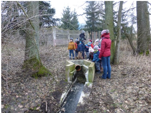
Odprowadzenie oczyszczonych ścieków do rzeki
